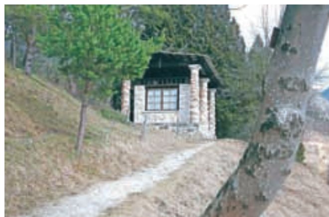
Oba Plečnikova objekta znotraj grajskega parka sta potrebna temeljite obnove. / FOTO: GORAZD KAVČIČ
